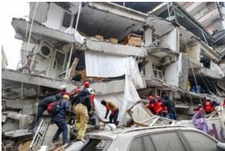
شکل (۱۹): ساختمان‌های آسیب دیده در زلزله ترکیه
